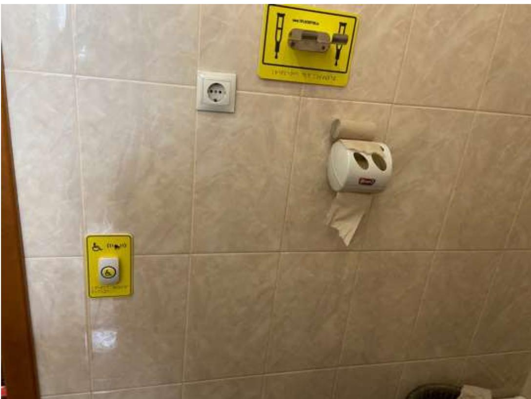
Рисунок 13. Кнопка вызова помощи и крючок для трости и костылей
