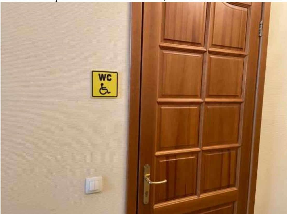
Рисунок 11. Обозначение санузла тактильной пиктограммой
